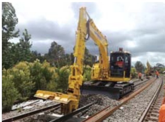
La PC138US con un accesorio Platypus utilizada en el proyecto de mejora de los ferrocarriles nacionales de Australia
